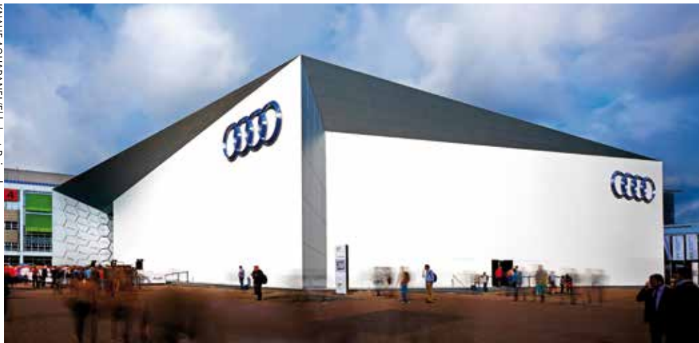
Die Fassade des temporären Gebäudes für Audi auf der IAA 2015 wurde mit der witterungsbeständigen Zementbauplatte Aquapanel Cement Board Outdoor geschlossen.
