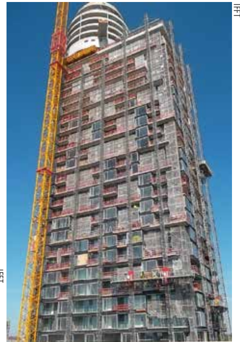
Wohnhochhaus Westseite Blick nach oben zum „Fass“.
