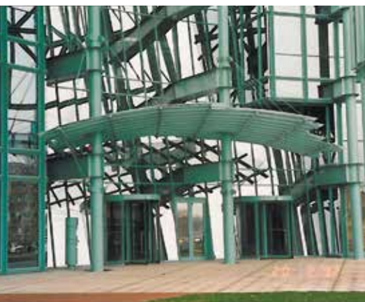
1992 am Reißbrett entwickelt mit W+M: Die Fassade des DER Reisebüros in Frankfurt/Main.
