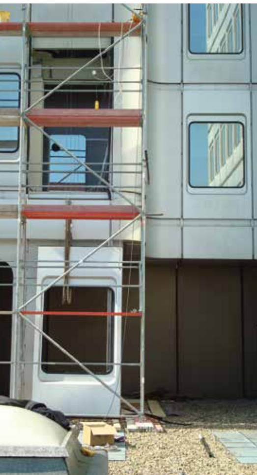
Beispiel eines demontierten Fassadenelementes zur Ist-Zustandsaufnahme.
