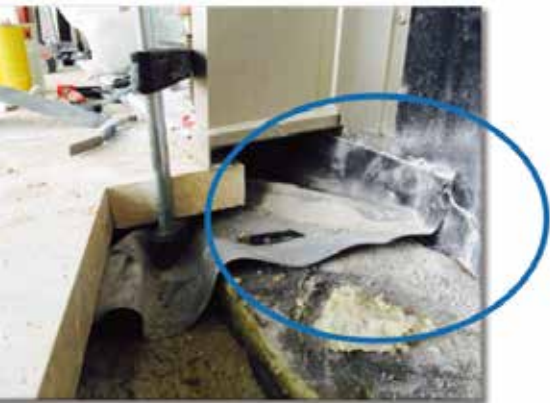
Abb. 2: Schleppfolie am Blendrahmen des Fensters zum Schutz der Wärmedämmung.
